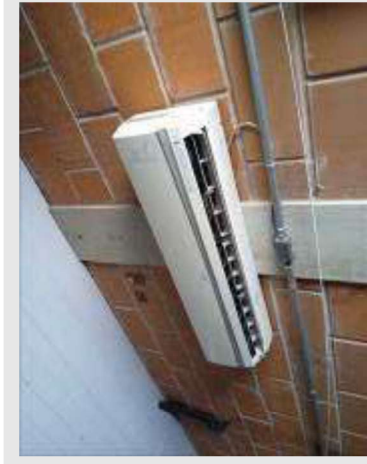
APARELHO CONDICIONADOR DE AR MARCA LG MOD TSNH2425MA1 POT 24000 BTU TENSÃO 220 V | Item: 691 |
