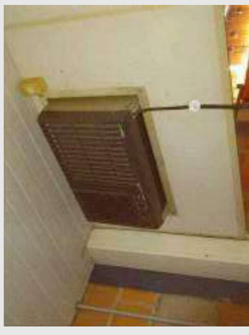
APARELHO CONDICIONADOR DE AR MARCA CONSUL MOD AIR MASTER POT 10000 BTU TENSÃO 220 V | Item: 291 |
