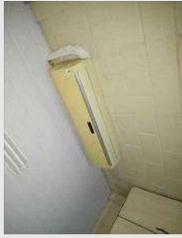
APARELHO CONDICIONADOR DE AR MARCA SPRINGER MOD MAXFLEX POT 6000 BTU TENSÃO 220 V | Item: 196 |
