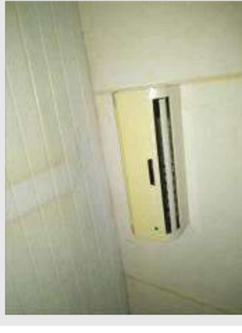
APARELHO CONDICIONADOR DE AR MARCA LG MOD TSNC2725MA0 POT 27000 BTU TENSÃO 220 V | Item: 288 |
