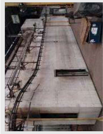
CABINE DE SECAGEM MARCA DELTEC DIM 30.0X4.0X4.0 M COM SISTEMA DE VENTILAÇÃO E EXAUSTÃO (1751) | Item: 361 |
